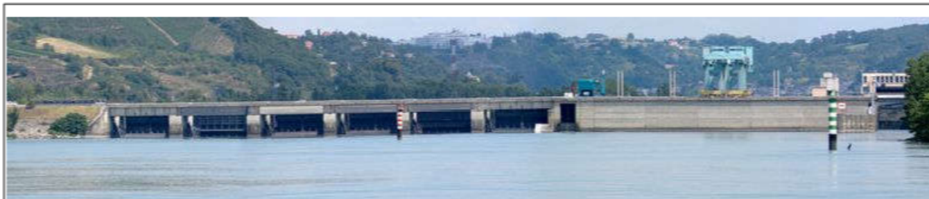
Illustration 1: Barrage de Vaugris
