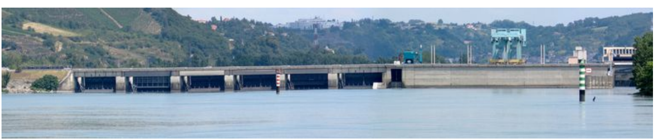
Illustration 1: Barrage de Vaugris
