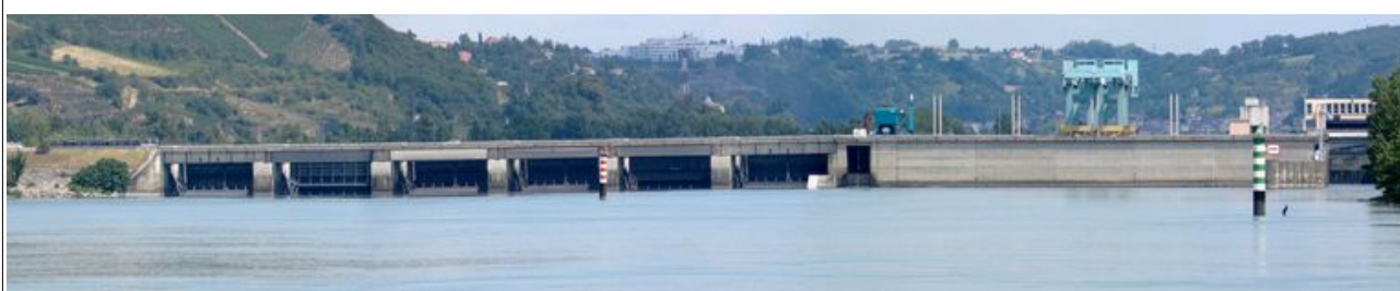
Illustration 1: Barrage de Vaugris
